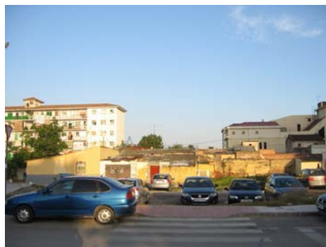
Fachada actual a C/ Pacifico
