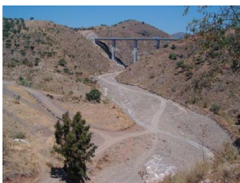
Arroyo Gálica y viaducto autovía
