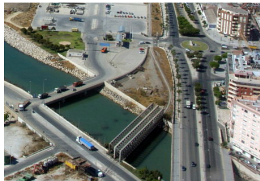
Puente actual del ferrocarril sobre el río
