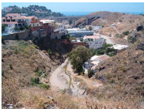
Cauce Arroyo Gálica y zona consolidada
