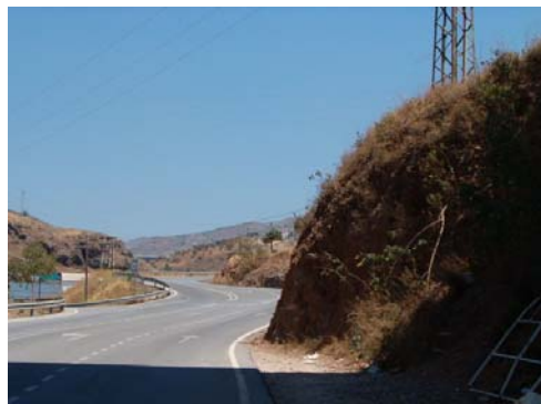
Inicio Carretera Olías
