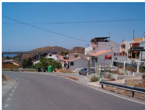
Carretera actual. Viaducto ronda circunvalación.
